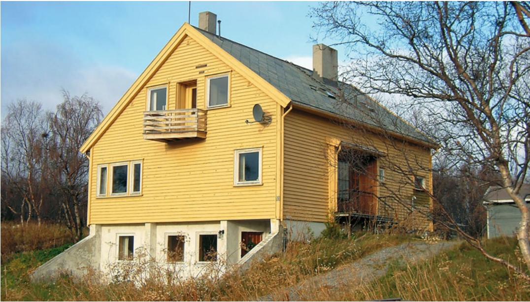
FIGUR 10. Overlegeboligene i Kirkenes er typiske for 1950-tallet, men samtidig spesielle. Bygningene ligger i skrånende terreng og har skjev røsting og orientering på tvers av hellingen. Den skjeve formen er ført videre mellom annet i balkong og inngangsparti. Foto Leif Maliks, utlånt av Helse- og omsorgsdept.
