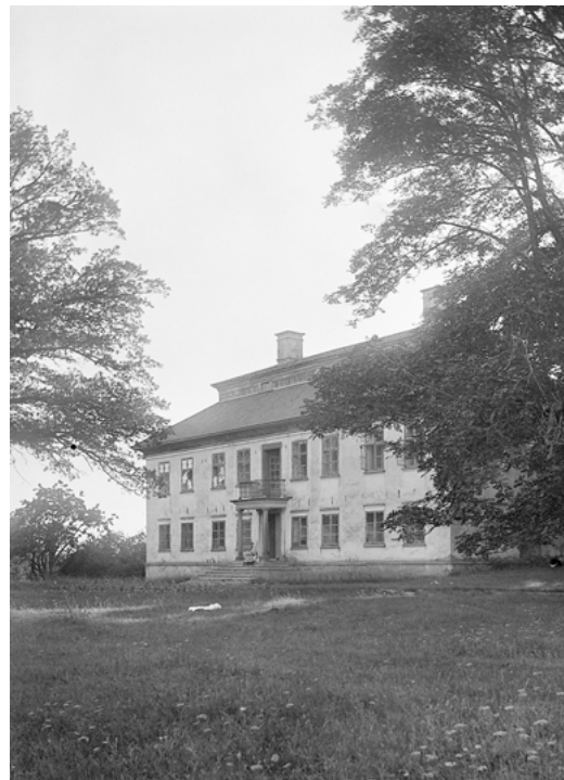
FIGUR 3. Stolas manbyggnad fotograferad av arkitekt Anders Roland 1905. Taktäckningen av spån är bytt mot tegelpannor, men i övrigt är exteriören oförändrad sedan 1700-talet. Foto i Västergötlands museums arkiv.
